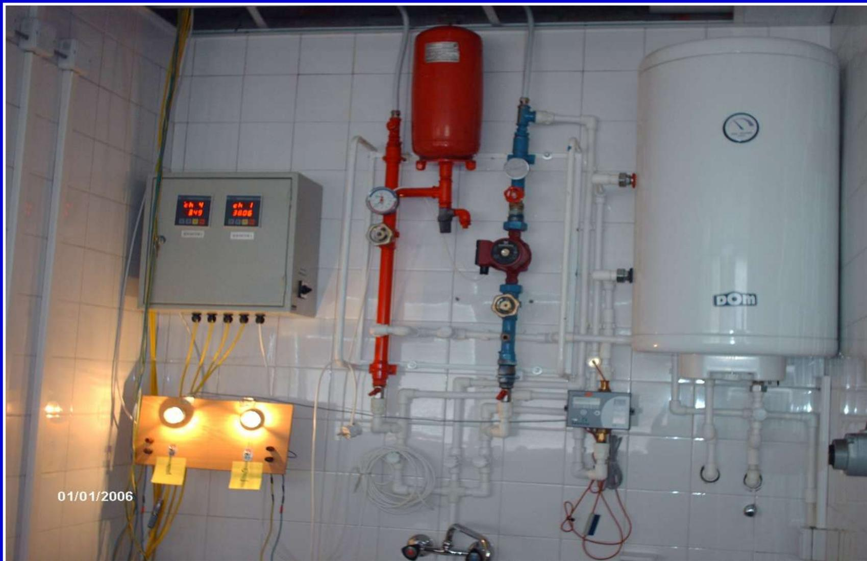
**Deo sistema za odredjivanje toplotnih i električnih karakteristika hibridnog kolektora**
