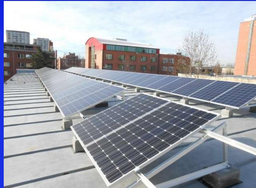
**PV elektrane FTS1 (levo; 9,6 kWp) i FTS2 (desno; 15,9 kWp) na krovu Fakulteta Tehničkih Nauka u Novom Sadu**
