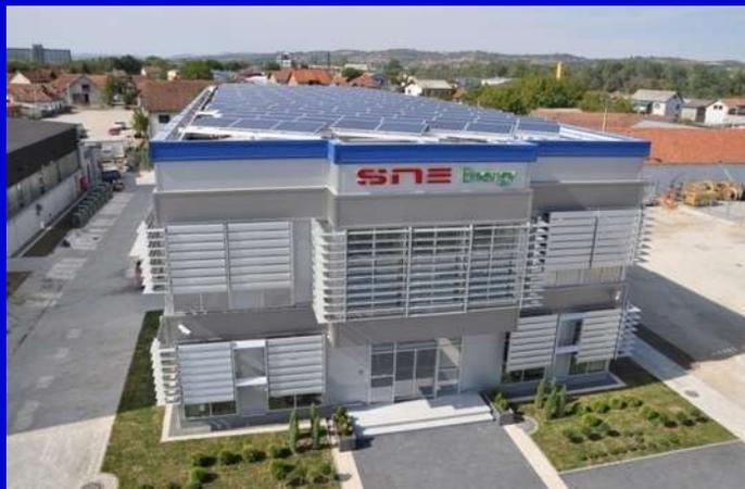
**PV elektrana na krovu firme *Elektrovat* u Čačku (54,72 kWp)**
