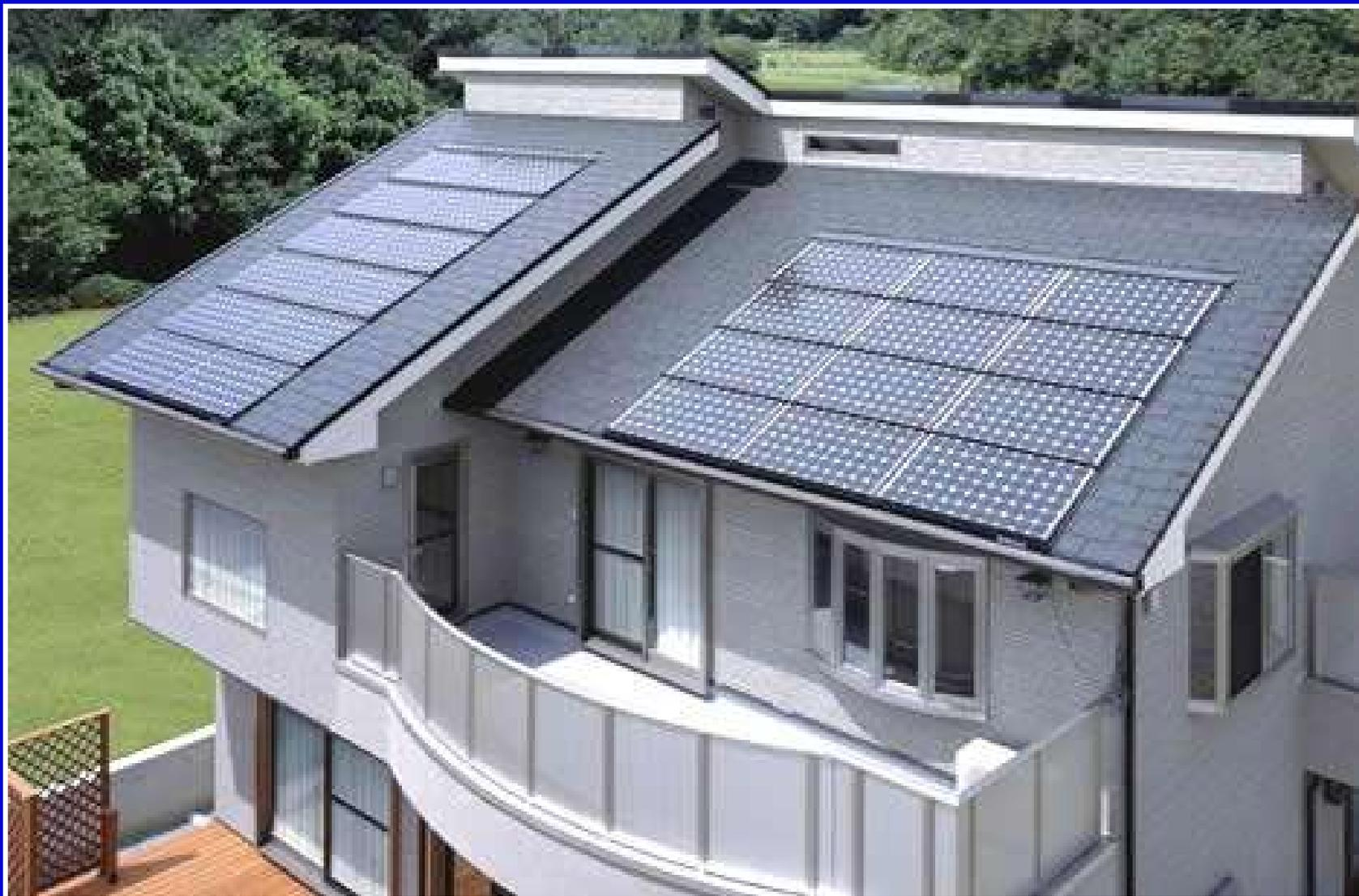
**Fotonaponski moduli na krovu kuće**
